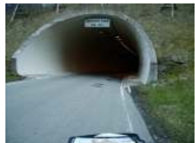
Tunnel bij Klösterle
